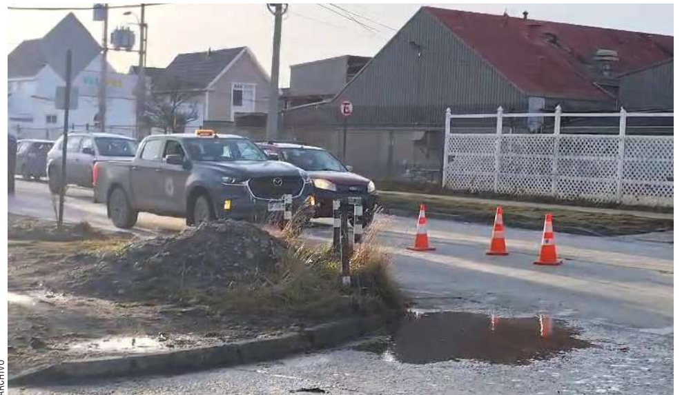
En este paso peatonal fue donde ocurrió el trágico accidente que cobró la vida de Yerka Filipich Águila.
