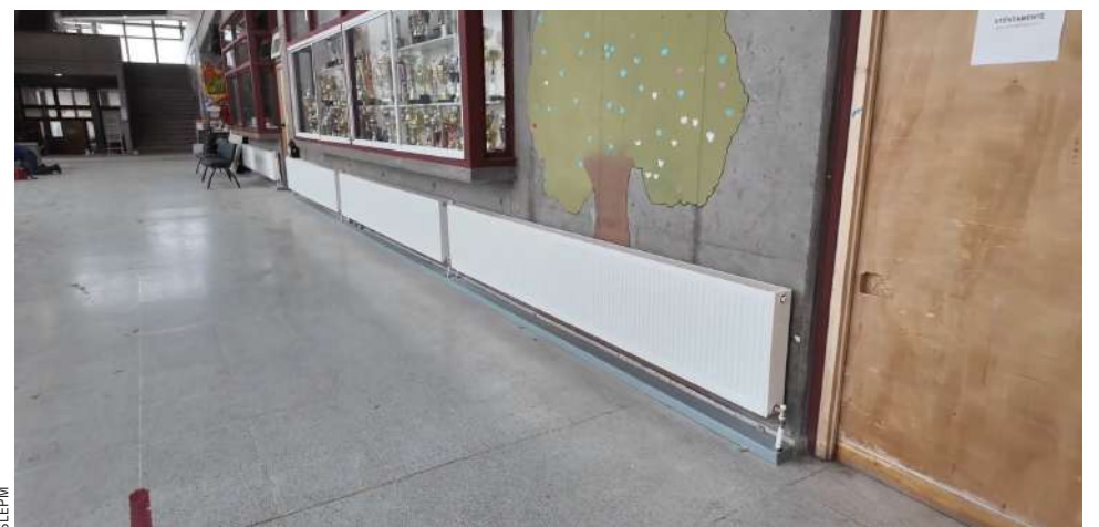
Las nueva calefacción ya están instalada en el patio común del liceo.
