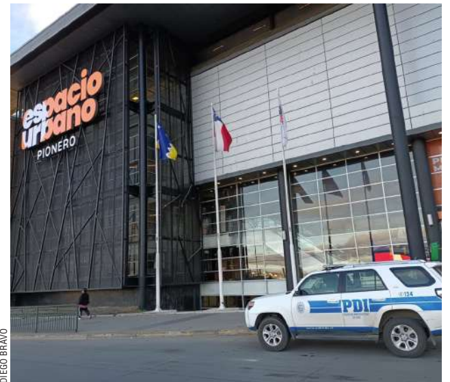
En el Mall Espacio Urbano, en Avenida Frei, se registró el fatal accidente.
