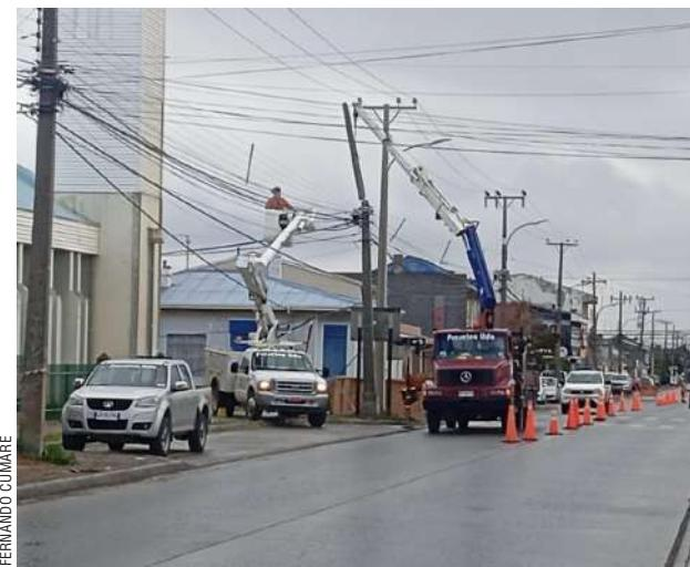
**Durante la mañana de ayer se efectuó un corte programado de electricidad en diversos sectores del Barrio Prat, para la sustitución de un poste del tendido eléctrico y la poda de árboles que topaban con el cableado, como medida preventiva.**
