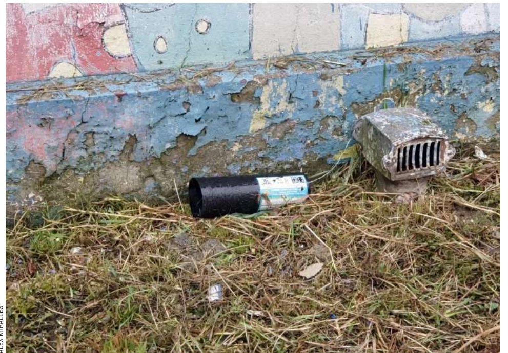
Dentro de las intervenciones a la ex Casa Azul del Arte estuvo la instalación de trampas para roedores.
