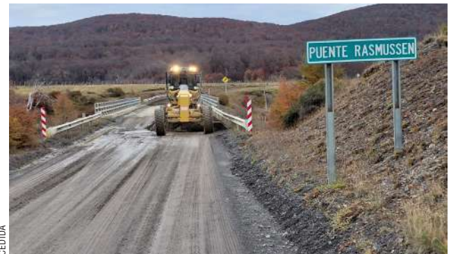
Ruta Y-85 Puente Rasmussen, Km 159.
