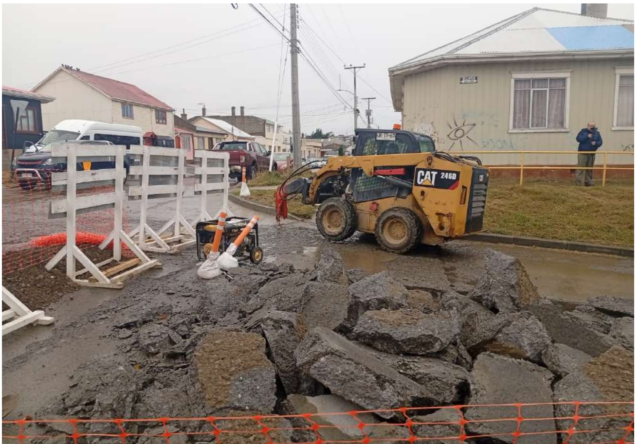
Ayer comenzó a despejarse el pavimento que estaba en Balmaceda entre Señoret y Av.España.
