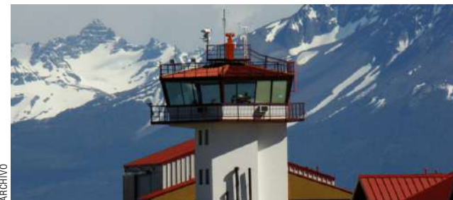
Las obras en el terminal aéreo están pactadas para enero-marzo de 2027.
