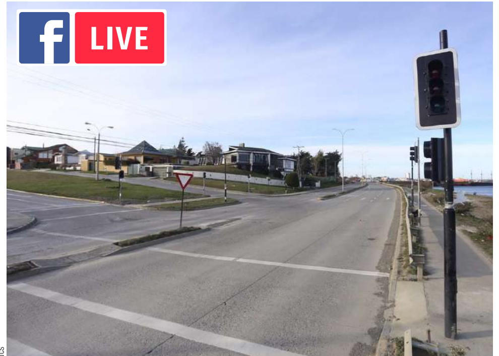
Estas fueron las estructuras que comenzaron a instalarse ayer en Punta Arenas, para el funcionamiento de los nuevos semáforos.
