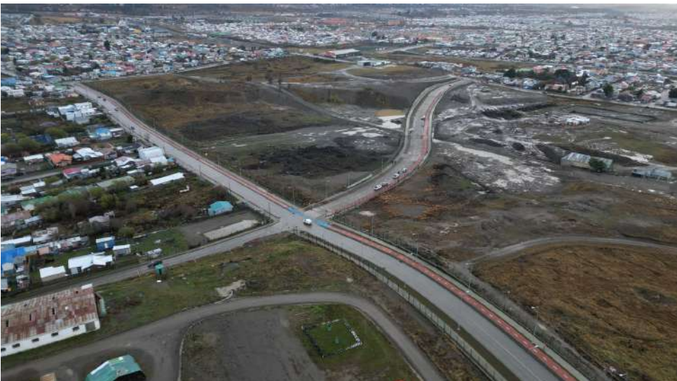
Una vista más amplia del sector de construcción que cuenta con la reciente calle Rancagua como divisoria.
