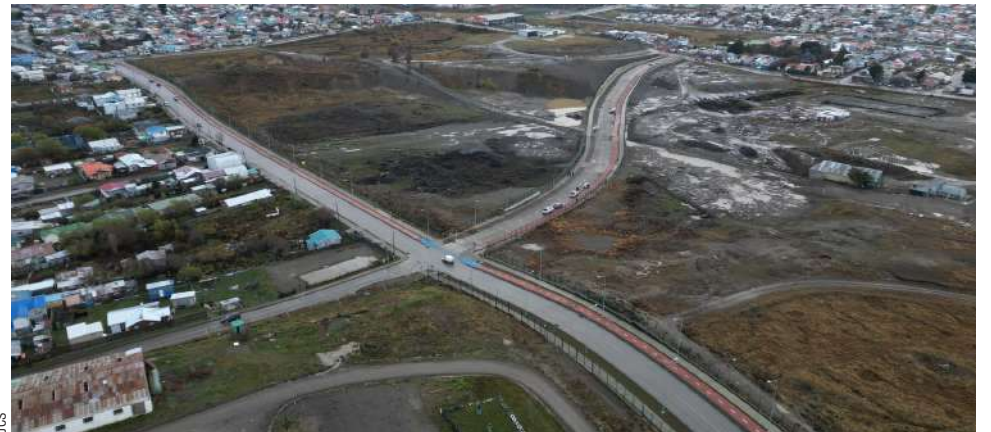
Desde Avenida Frei hasta Zenteno, en paralelo a Fagnano se construirán estas viviendas sociales.
