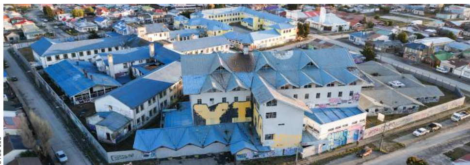
Ayer se completó el cierre perimetral del antiguo edificio de Punta Arenas.
