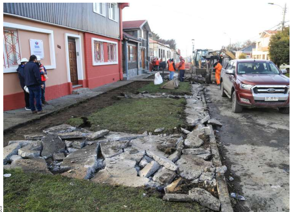
Desde temprano comenzó el retiro de estas veredas en mal estado que serán repuestas con el proyecto.
