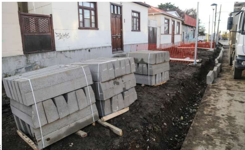
Parte de los bloques que se instalarán en este cuadrante del centro.
