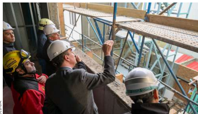
Para diciembre contemplan la entrega final de las obras.
